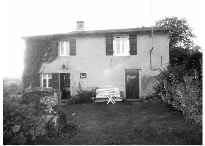
Façade est de la maison de l'Orme dans son état actuel
